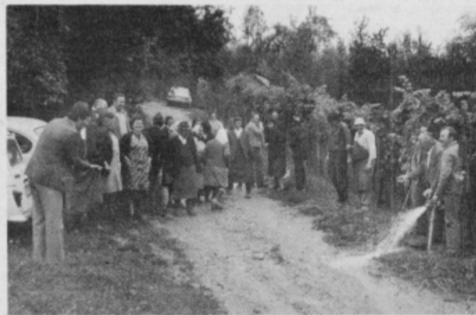
Ob robu vinograda so odprli hidrant in Janko Matjašič je navzoče poškopril z vodo. (Foto: JOS)
