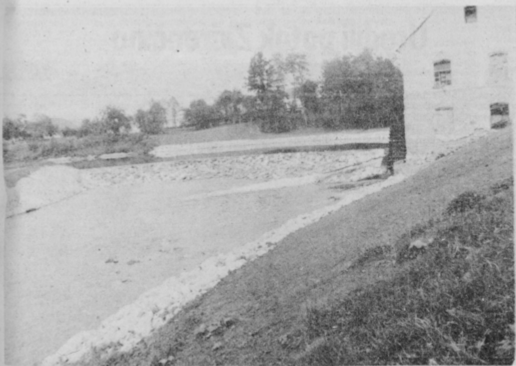
Najzahtevnejše gradbišče doslej — jez v Jurovcih.
