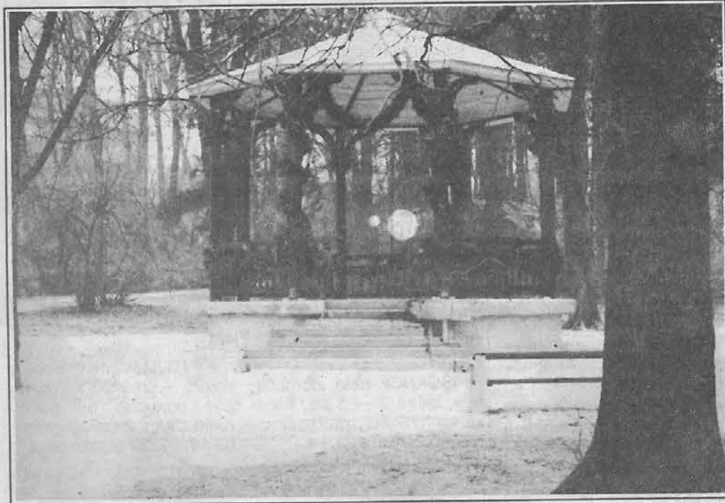
Glasbeni paviljon je postavljen, do leta 1995 pa naj bi Ljudski vrt v celoti obnovili. Foto: M. Zupanič
