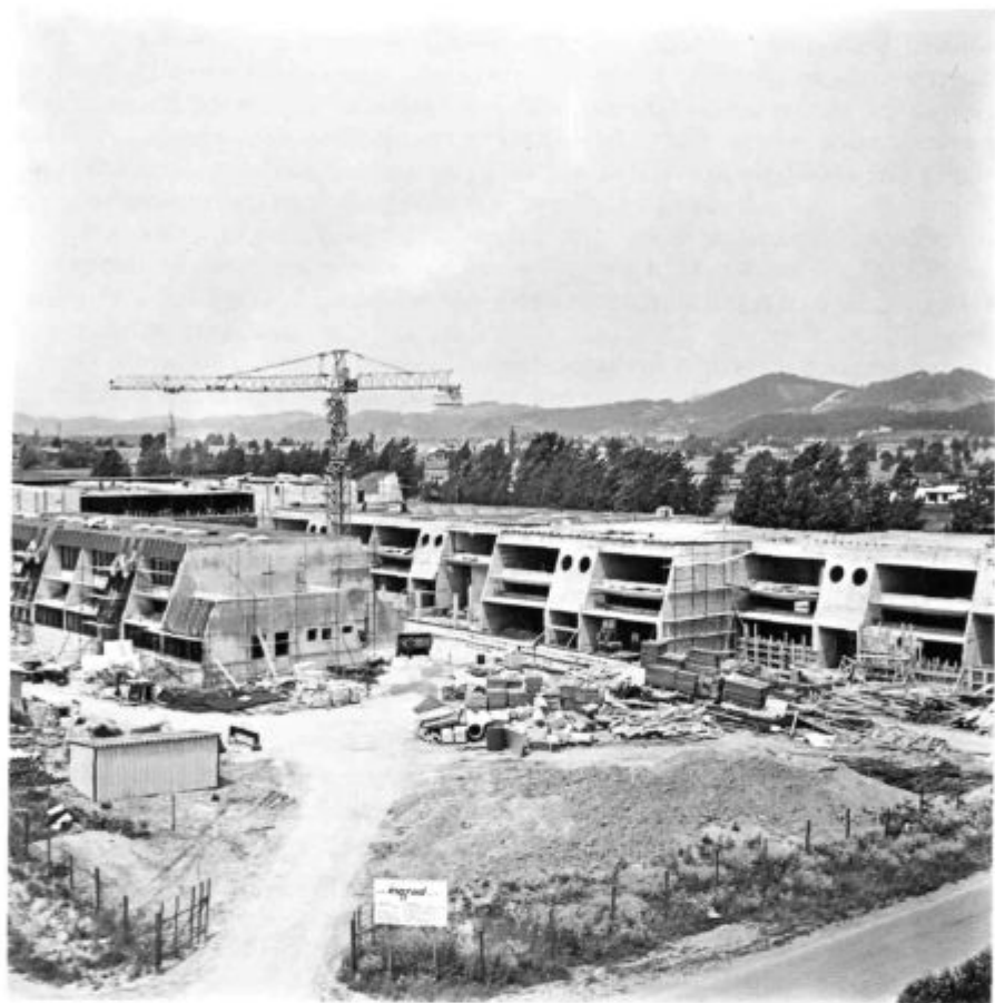
Osnovnošolski center Žalec v izgradnji
