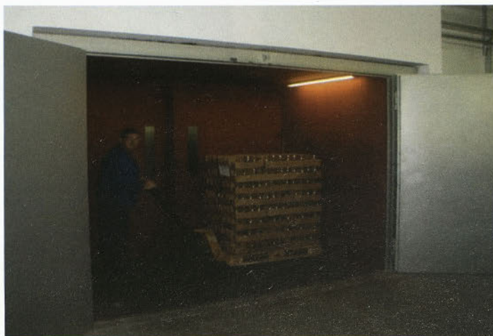
Dvigalo, s katerim prevažamo ves potreben material iz enega v drugo nadstropje.
