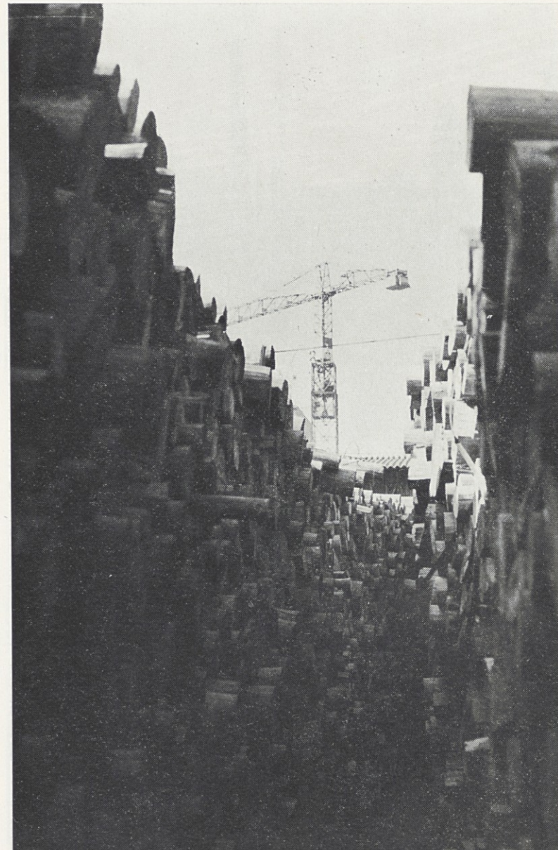
Skladišče lesa, v ozadju gradnja V. PS
