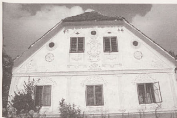
Pogled na JV stransko fasado, 1996 (Foto: Tanja Hohneck)
