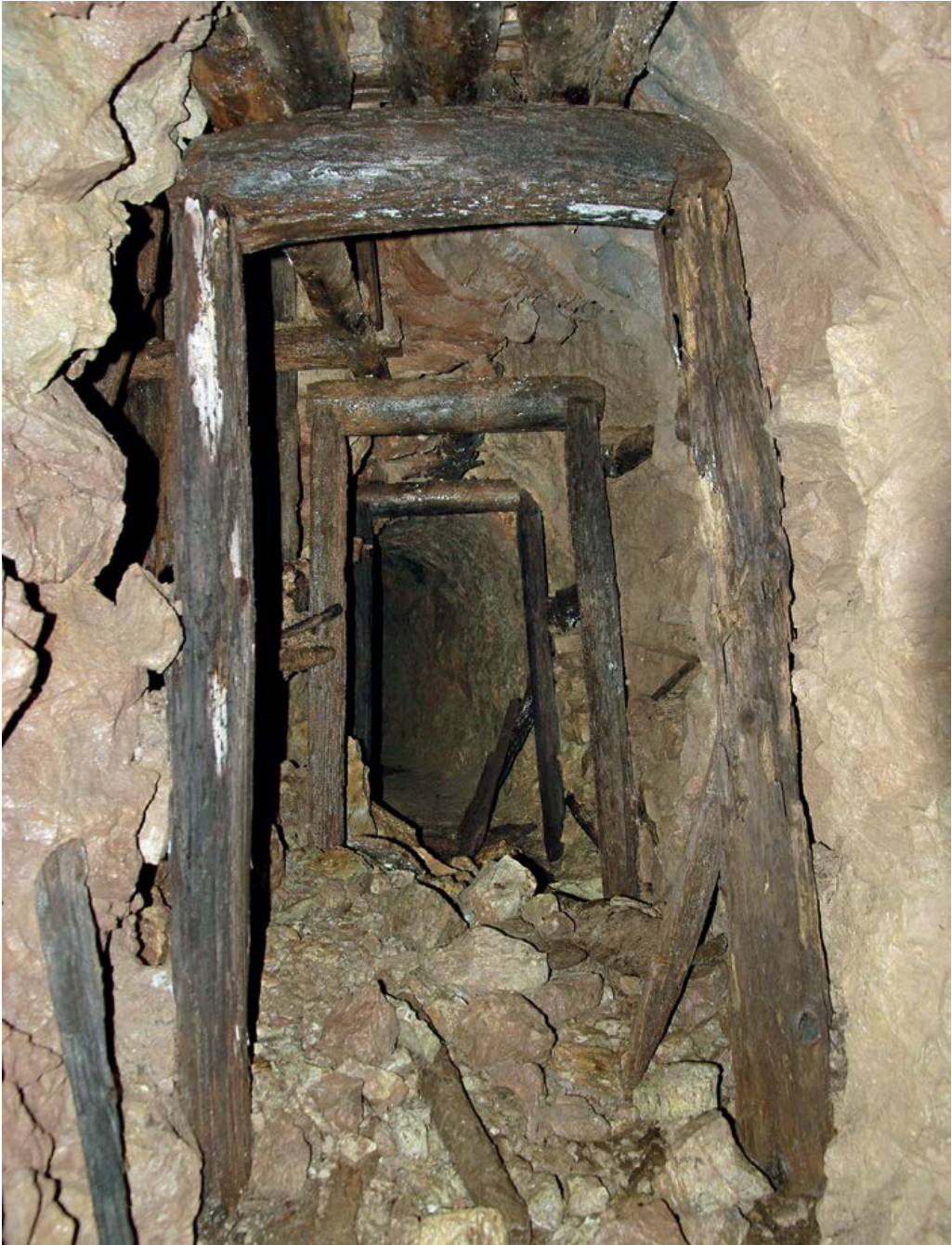
Slika 4. Že omenjeni rov na Begunjščici z značilno rahlo trapezasto tesarbo, ki je postala znak za rudnik; stanje junija 2011.
