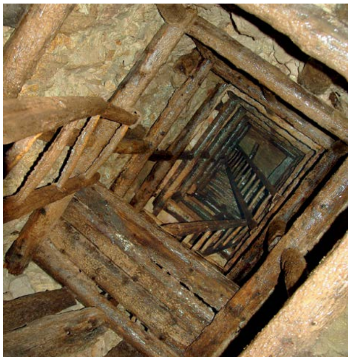
Slika 13. ... morda je bil dostop v jamo po povsem obtesarjenem jašku, kakšen je zračnik v rudniku manganove rude na Begunjščici; stanje junija 2011 ...
