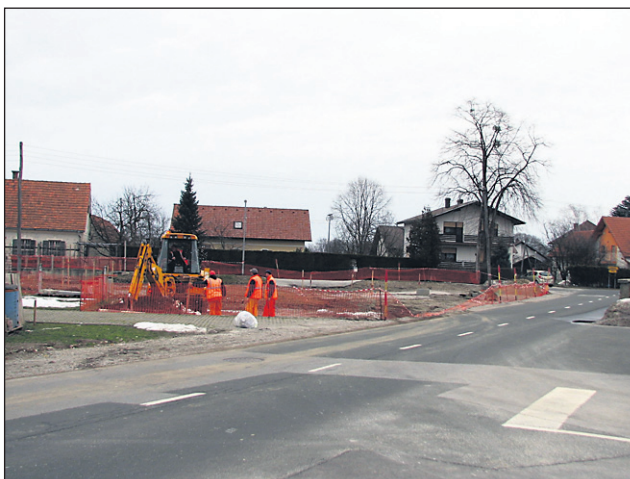
Delavci Cestnega podjetja Ptuj so v teh dneh, potem ko so bili rešeni zapleti z odkupom zasebnih zemljišč, že začeli gradnjo.
