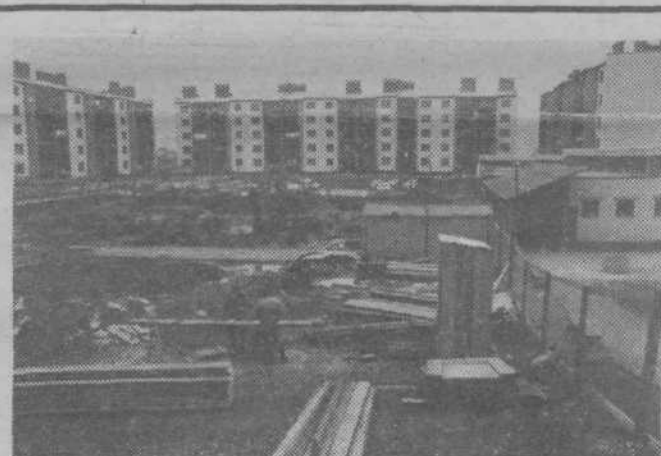
Gradnja prizidka k vrtcu v Novih Jaršah
