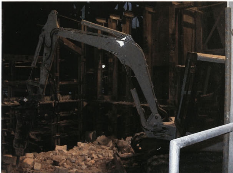
Podiranje peči z bagerjem (Pavčnik)
