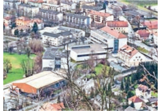
Projekt za gradnjo nove Osnovne šole Frana Albrehta je občina prijavila tudi na državni razpis za sofinanciranje tovrstnih občinskih naložb.
