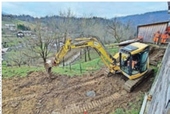
Gradnja kanalizacije za odpadne vode na območju Porebra
