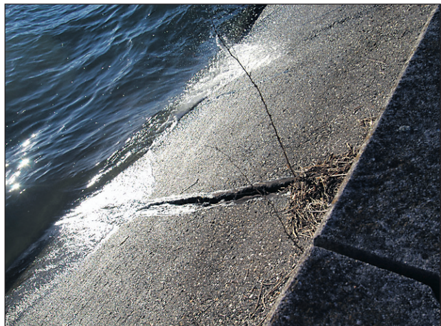
Zaradi takih razpok na asfaltnih brežinah okrog jezera se krajanj okoliških vasi čutijo ogroženi.
