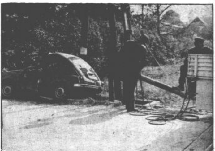
Zaradi neprimerne hitrosti v zapornice
