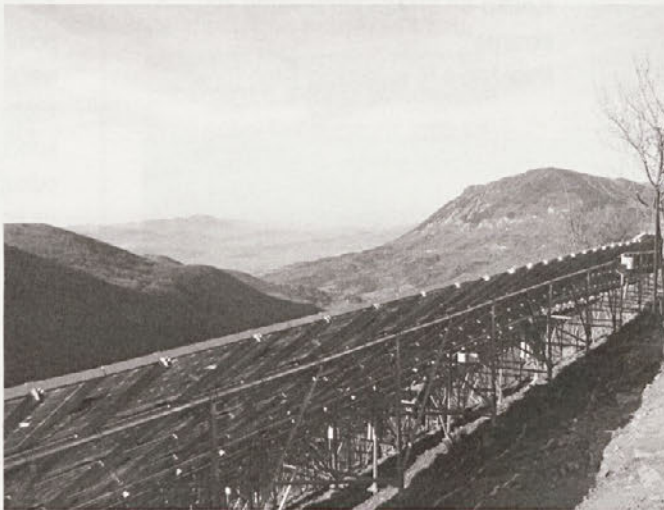
Foto: Pogled na polje sončnih panelov v Višnjah z zgornje strani. Foto: Katja Lampe
