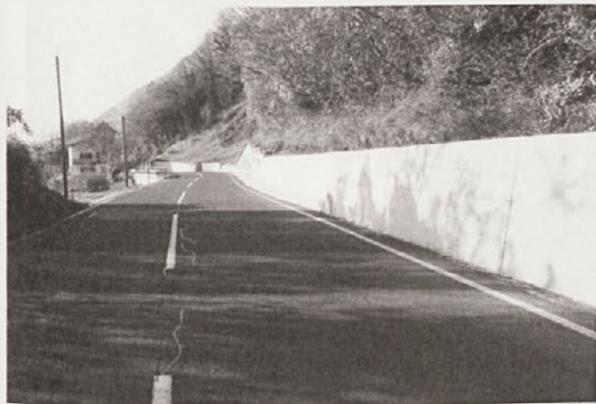
Novi zid nad cesto Ajdovščina/Col pri Colu. Foto: Tim Žgavec
