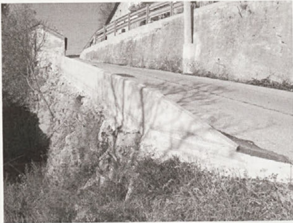
Obnovljen podporni zid v Orešju. Foto: Luka Bizjak
