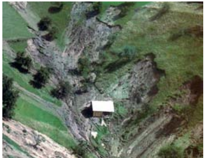
Sliki 3,4: Usad v Halozah ter vas Šmarje pri Kopru. S poznavanjem nevarnosti ter z ustrezno izbiro lokacije se lahko marsikateri nevarnosti izognemo. Vas, zgrajena na sllemenu je glede usadov in zemeljskih plazov bistveno varnejša kot zgradbe v grapah. (Vir: Orožen Adamič, M., Plazovi v Halozah. UJMA 1990. , Uprava RS za zaščito in reševanje Ministrstva za obrambo, str. 1 (naslovnica); Simič Sime, S., 2001: Slovenska Istra - zaledje. IKI doo, Ljubljana, 78.) Landslide in Haloze and the village Šmarje near Koper. Knowledge about hazards and thus conditioned choice of sites can prevent many calamities. Concerning landslides, a village built on a ridge is much safer than houses built in the ravine.
