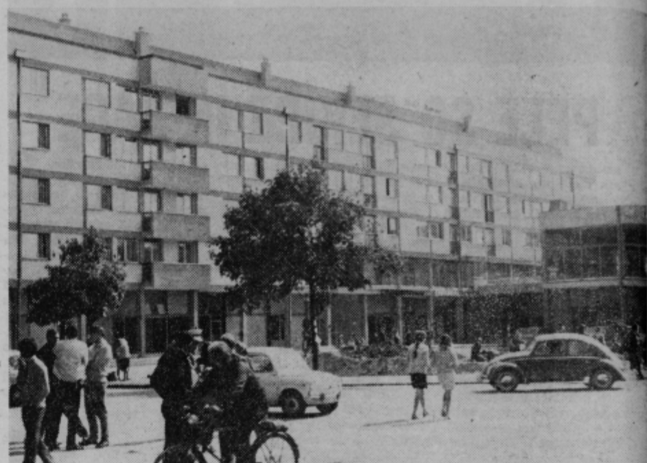
Središče Čuprije z novozgrajenim hotelom »Ravno« v ozadju. Pred hotelom so v zaključni fazi dela pri urejanju zelenic in vodometov
