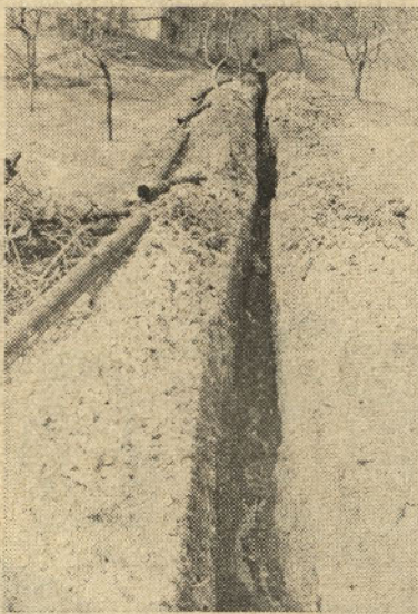
Gradnja vodovoda se bliža rezervoarju v Studencah
