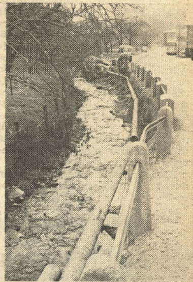
Polaganje vodovoda v soteski Boben. Delo je zelo naporno
