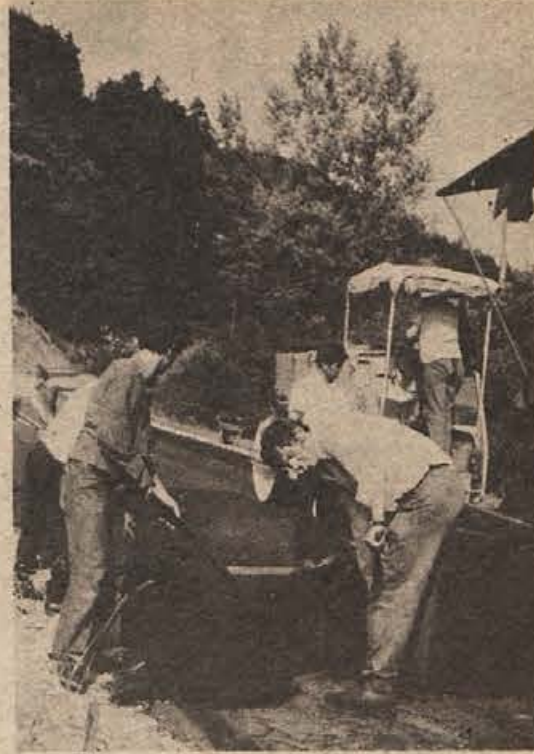
Denar le do Pekla? Kaže, da se bo na cesti proti Planini delo za letošnje nehalo, čeprav je zaenkrat tam dokaj živo. Na sliki: še v soboto popoldne so novomeški cestarji hiteli polagati zaporni asfaltni sloj od 4. do 8. kilometra ceste Sevnica-Planina. (Foto: Železnik)
