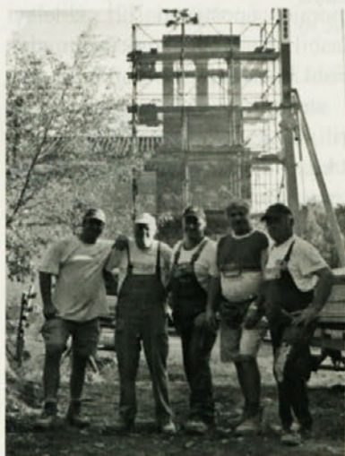
Gradnja novega zvonika sv. Pavel, Vrtovin 2013
