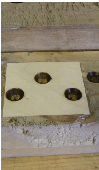
Sl. 4. Rekonstrukcija uničenega dela lesene notranjosti.
