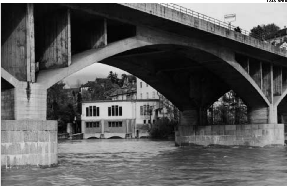
Hidroelektrarna Sava v Kranju.
