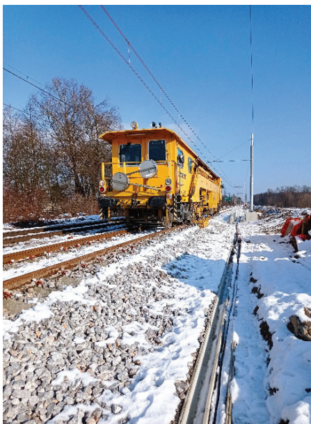
Slika 7. Regulacija tira v Gmajnicah – levi tir.
