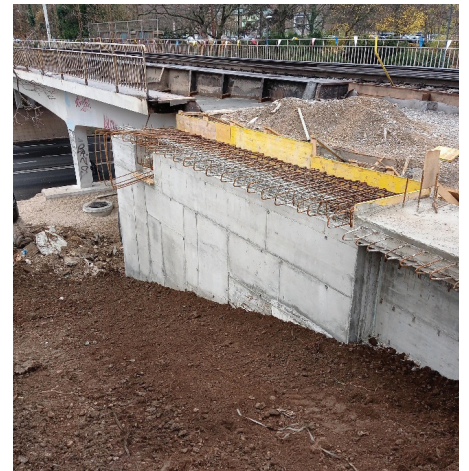
Slika 5. Sanacija železniškega nadvoza na Celovški cesti.
