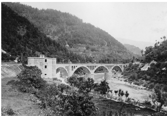
Slika 6. Ob mostu je stala na desnem bregu Soče velika stražarnica za čuvanje mostu. Foto: arhiv Tolminskega muzeja [Tolminski muzej, 2020].
