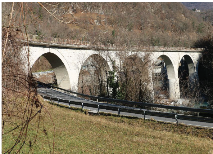
Slika 15. Novi most v Ajbi ima večji del fasade mostu na površinah med posameznimi loki obdane s klesanim kamnom. Foto: Gorazd Humar, jan. 2022 [Humar, 2022].
