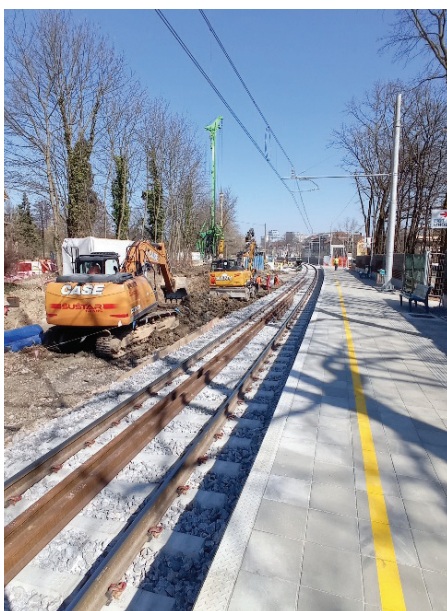
Slika 10. Izkopavanje spodnjega ustroja ob postajališču Tivoli – desni tir.
