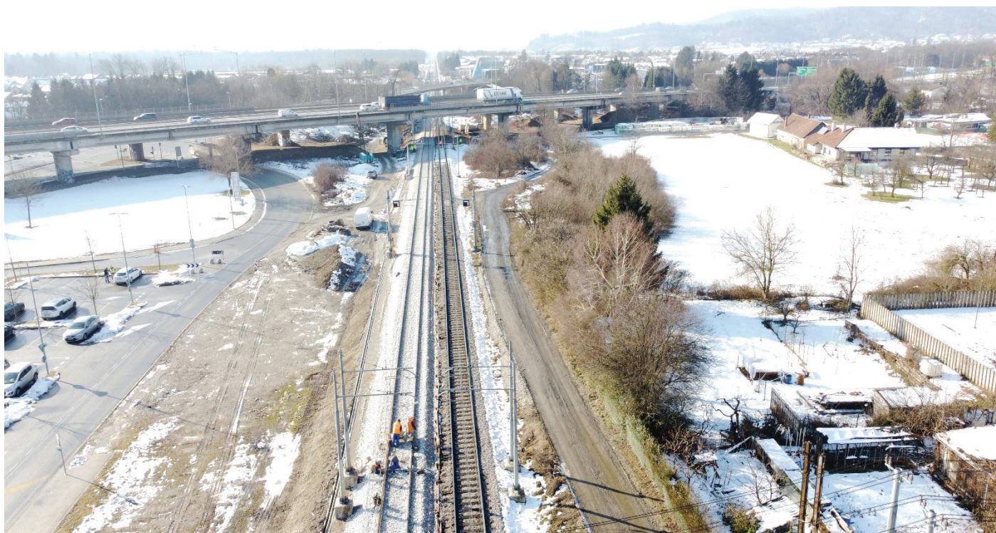
Slika 1. Nadgradnja levega tira na odseku Ljubljana-Brezovica.
