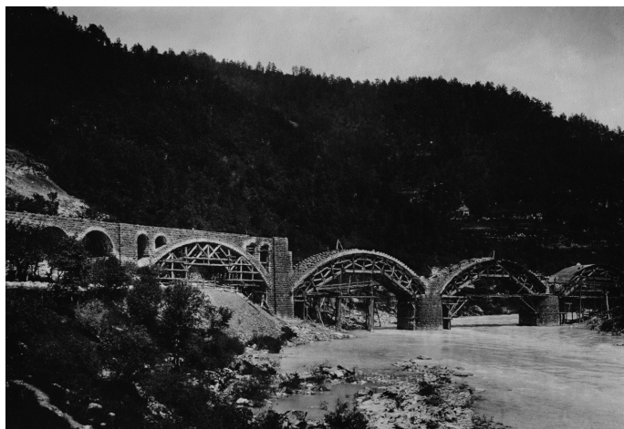
Slika 4. Gradnja kamnitih lokov je potekala postopno s podpiranjem na lesenih podpornih odrih. Posnetek je nastal julija 1905. Foto: arhiv Tolminkskega muzeja [Tolminski muzej, 2020].
