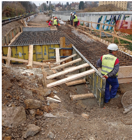
Slika 4. Sanacija podhoda pri parkirišču Tobačna.
