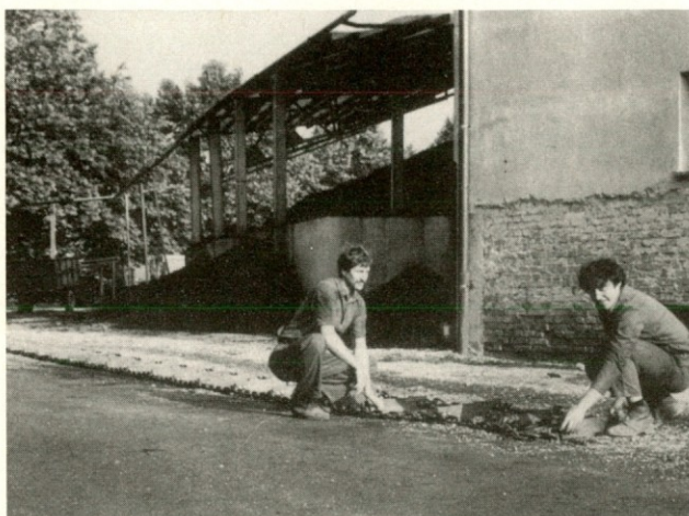
Precej dela so imeli med remontom tudi v kotlarni. Na sliki sta BOJAN SLAPAR in TONE ŠUŠTAR pri popravilu tekočega traku, kjer je bilo potrebno menjati vodilne valjčke in dele traku.
