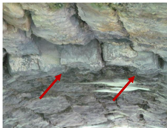
Slika 5.10: Propadla malta in izpadli kamni iz kamnitega oboka mostu LJ 0289
