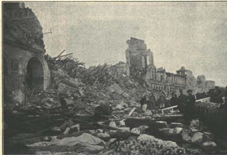
V pristanišču po potresu.
