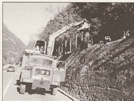
Domiselni pripomoček za kopanje temeljev in betoniranje nosilcev mreže (foto MM)
