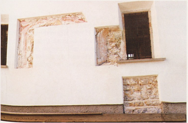
Ostanek romanske in gotske arhitekture. Spodaj je odkriti del plastilne gradnje, nad njo ostanek levega dela gotskega okna in del freske Jerneja iz Loke.
