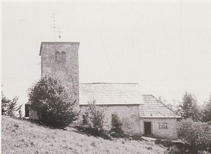
Zunanjščina Miklavževe cerkve s severozahodne strani okoli leta 1969.
