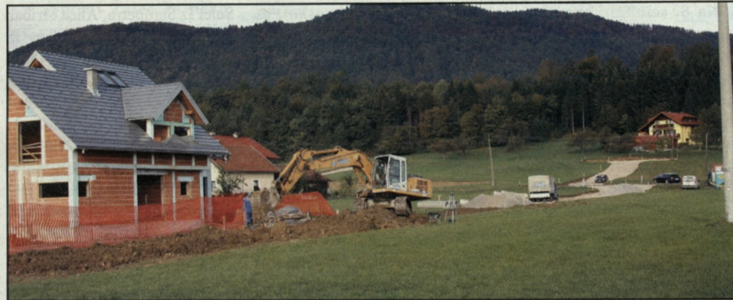
Začetek gradbenih del na Terasah III
