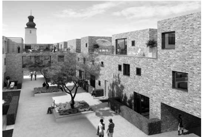
Slika 2: Pogled na stanovanjski sestav, ki upošteva standarde za projektiranje za stare ljudi v mestu Köln (Sülz BF4) v Nemčiji [Juan Pablo Molestina].
