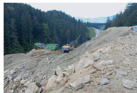
Slika 12. Drobljenje izkopanega materiala pred transportom na začasno odlagališče v območju priključka Podgorje na sklopu G, september 2022 (Foto: DARS, d. d.).
