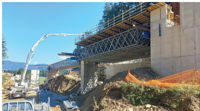
Slika 7. Podkonstrukcija 1. in 2. polja viadukta Višočnik, september 2022 (Foto: DARS, d. d.).
