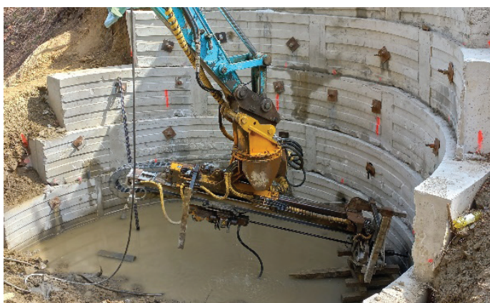
Slika 8. Stabilizacija brežine s sidranjem delnih prstanov za izvedbo plitvega temelja stebra viadukta Višočnik, april 2022 (Foto: DARS, d. d.).
