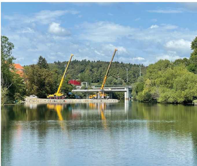
Slika 6. Montaža prvih segmentov, avgust 2022 (foto: Karol Žužek).
