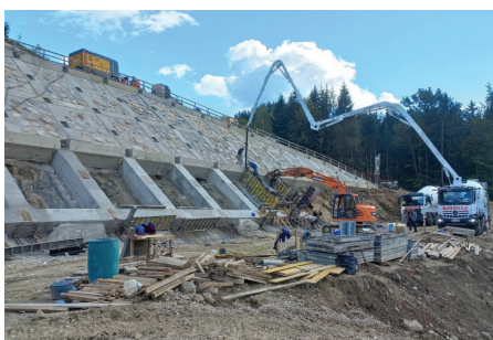
Slika 11. Betoniranje vertikalnega slopa na zgornji etaži oporne konstrukcije 10_OK-40, september 2022 (Foto: DARS, d. d.).
