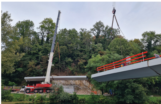
Slika 8 in 9. Montaža segmentov z dvema 220-tonskima avtodvigaloma proti levemu bregu reke Krke, september 2022 (foto: Danilo Malnar).
