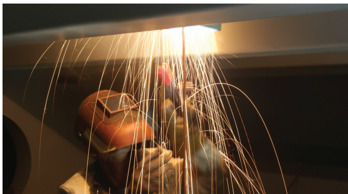
Slika 12 in 13. Varjenje v mostni konstrukciji (foto: Karol Žužek).
