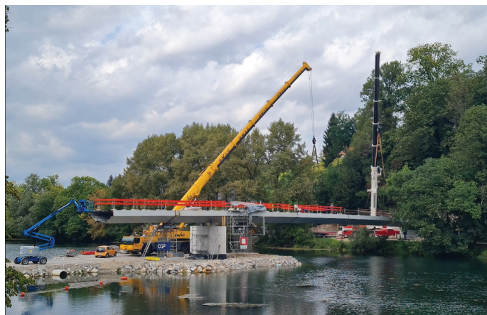
Slika 8 in 9. Montaža segmentov z dvema 220-tonskima avtodvigaloma proti levemu bregu reke Krke, september 2022 (foto: Danilo Malnar).
