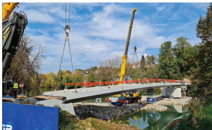
Slika 11. Montaža segmentov na desnem bregu reke Krke, začetek oktobra 2022 (foto: Danilo Malnar).
