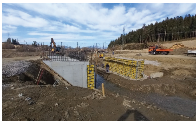
Slika 9. Izvedba krajnih opornikov mosta Jenina, marec 2022 (Foto: DARS, d. d.).
