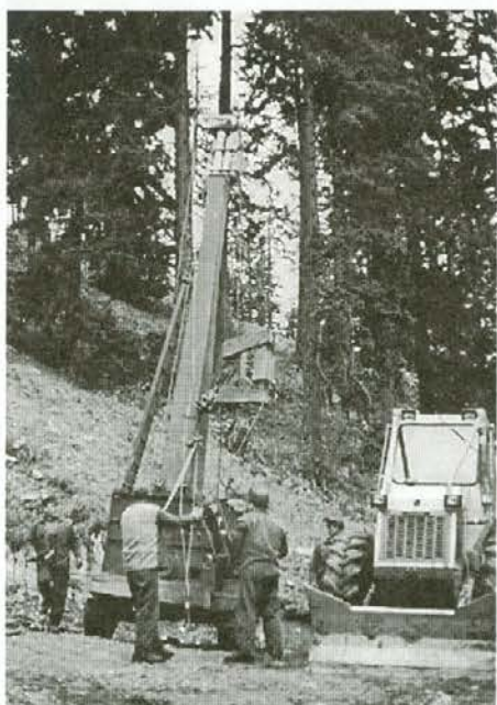
Demontaža linije in priprava za premik
