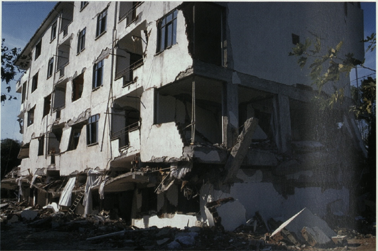
Slika 10. V šestnadstropnem okviru s polnilom sta se zrušili dve etaži
