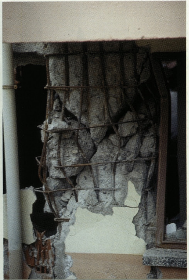
Slika 12. Šibka stremena niso mogla preprečiti zdrobitve jedra stebra
