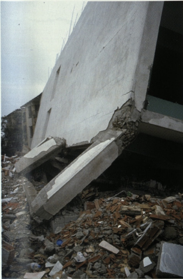
Slika 11. Značilna porušitev stebrov v šibki smeri
