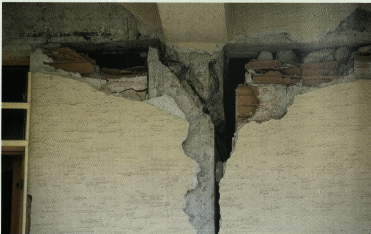
Slika 8. Strižna porušitev "kratkega stebra" ob polnilu
