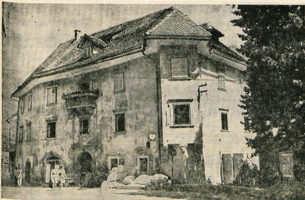
Obnova zunanosti in notranosti Homanove hiše, čudovite srednjeveške stavbe na Mestnem trgu v Škofji Loki, se vleče že kar predolgo. — Foto: F. Perdan
