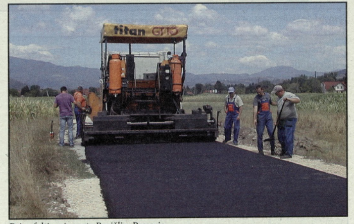
Pri asfaltiranju ceste Parizlje-Preserje
