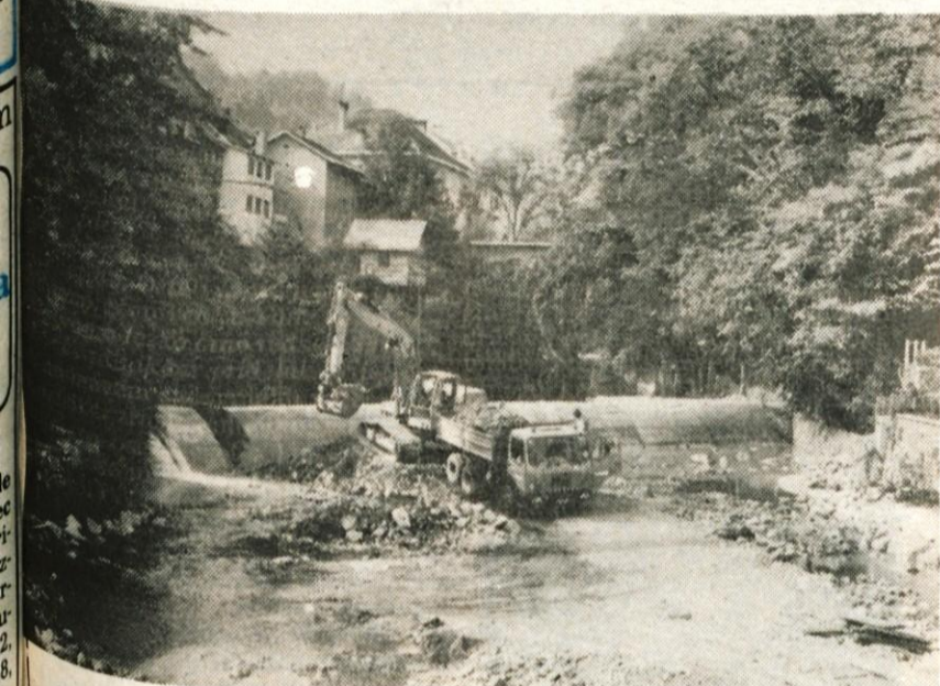
Škofja Loka — Delavci vodnogospodarskega podjetja iz Kranja obnavljajo Seširjev jez na Selški Sori. Denar za obnovo sta prispevala Območna vodna skupnost in Tovarna klobukov Sešir. Sešir naj bi na novem jezcu zgradil malo hidroelektrarno za pogon obrata na Spodnjem trgu. Tako naj bi jez spet služil prvotnemu namenu, saj je pred skoraj sto leti na tem mestu stala Krenejeva elektrarna. — Foto: F. Perdan
