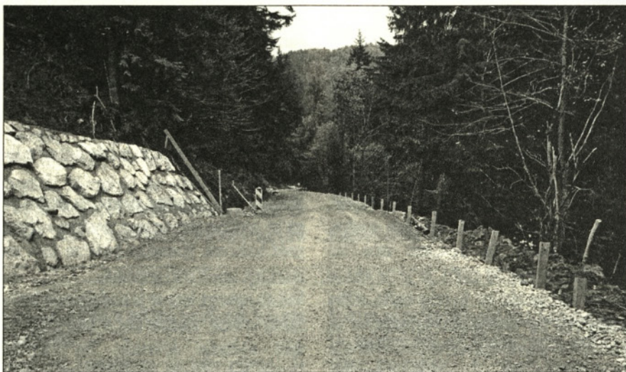
Sanacija plazu na cesti Smrečje - Podlesec. (foto: Rafael Krvina)
