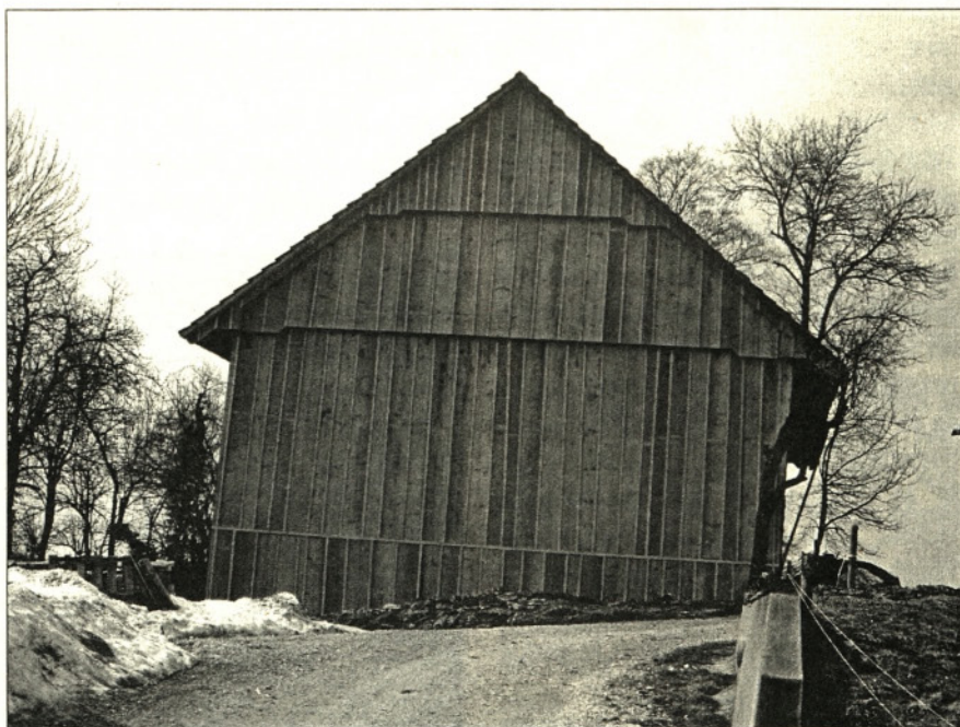
Sokrajanji so združili dobro voljo in moči ob obnovi Toncovega hleva. Na sliki sadovi dela. (foto: Rafael Krvina)
