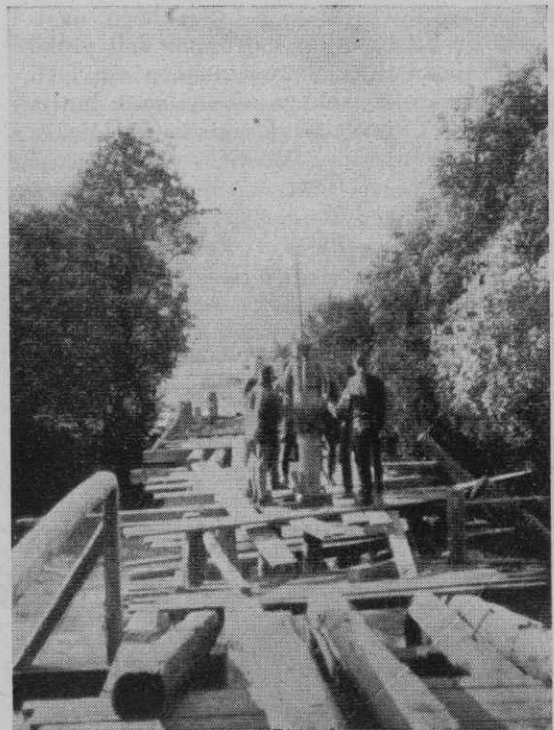
Gradnja mostu čez Krko (julij 1919)
