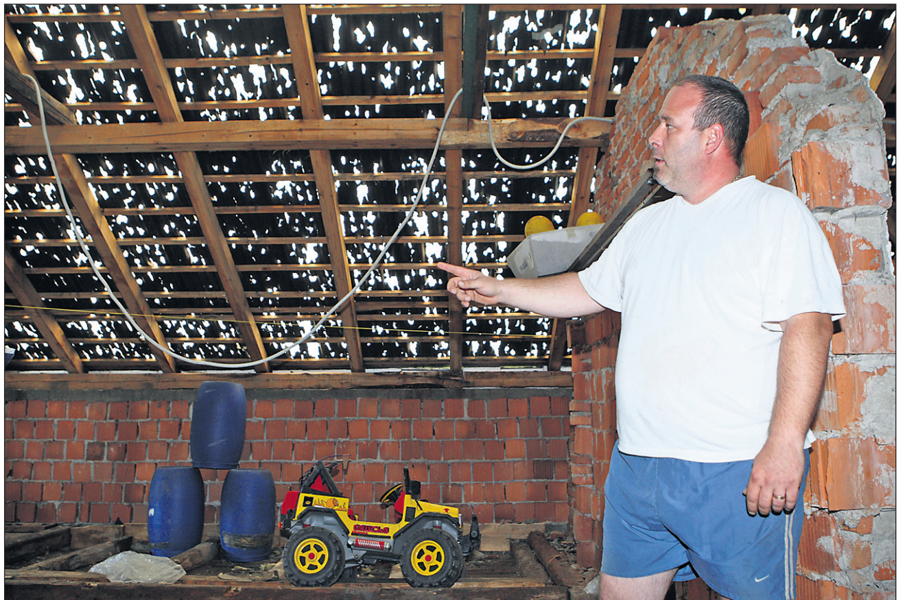
Toča je v občini Hajdina najmočnejše udarila v stanovanjsko hišo Dagmarja Novaka v Slovenji vasi 56. Vodo in točo, bilo je je do gležnjev, so odstranjevali celo noč. Poškodbe so tako hude, da je sanacija vprašljiva.
