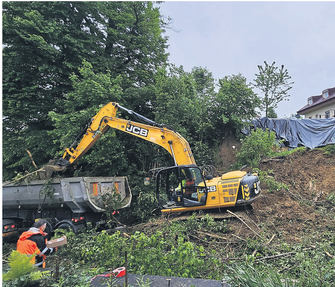
Sanacija plazu pri križišču med Drbetinci in Vitomarci
