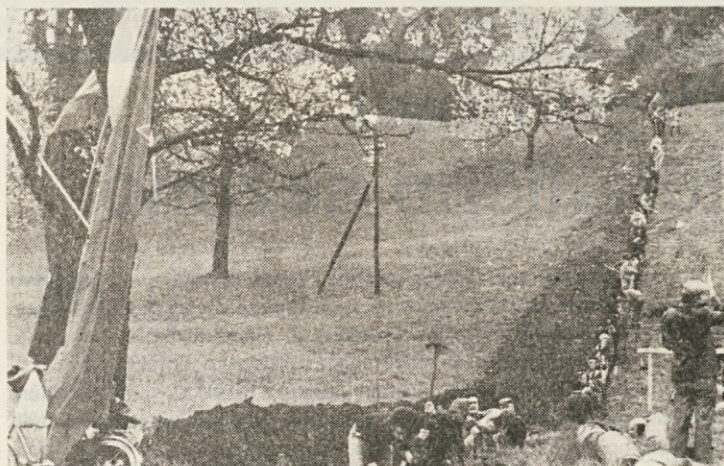
Udeleženci akcije pri gradnji kanalizacije
