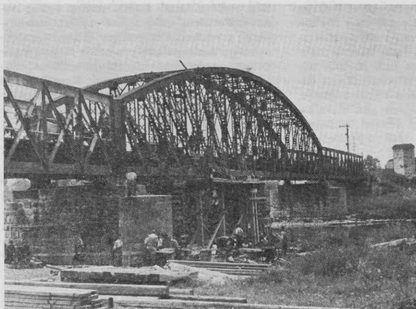
Obnavljanje črnuškega mostu maja 1945 (Fototeka MLRS)
