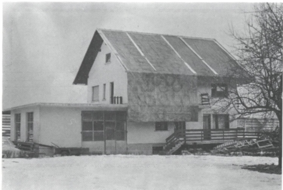
Sl. 12. Takole so začasno pokrili razkrito streho na Brezjah.
