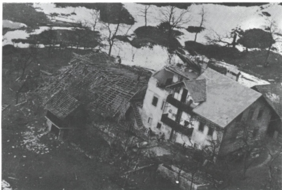
Sl. 4. Slika prikazuje razdejanje, ki ga je povzročil veter na kmetiji Marije Balant štev. 29 v Smokuču pri Žirovnici. Hiša stoji na samem nadvasju in je bila zato še posebno močno izpostavljena vetru. Čeprav so nekoliko manj prizadeti del strehe že pokrili, pa njen razkriti del, povsem uničen skedenj, hlev in lopa pod njim pričajo o silovitem viharju.
