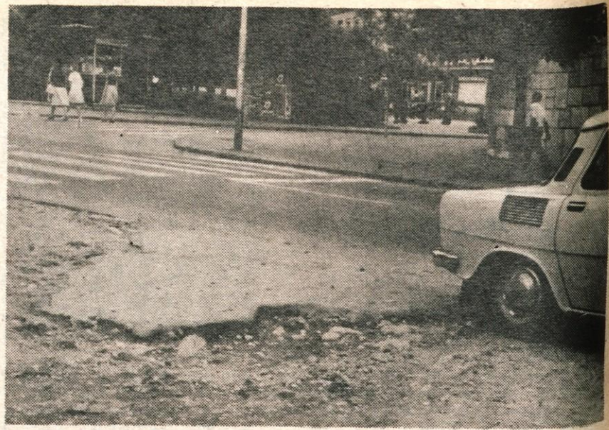
RAZRITO PARKIRIŠČE PRI BEKSELNU - Na prostoru nekdanjega Bekselna v Kranju pri bifeju Turist je že precej dolgo parkirni prostor. Žal ni najboljše urejen. Zaradi lukenj in razpadajočega asfalta je marsikaterega voznika strah zapeljati nanj - Foto: F. Perdan
