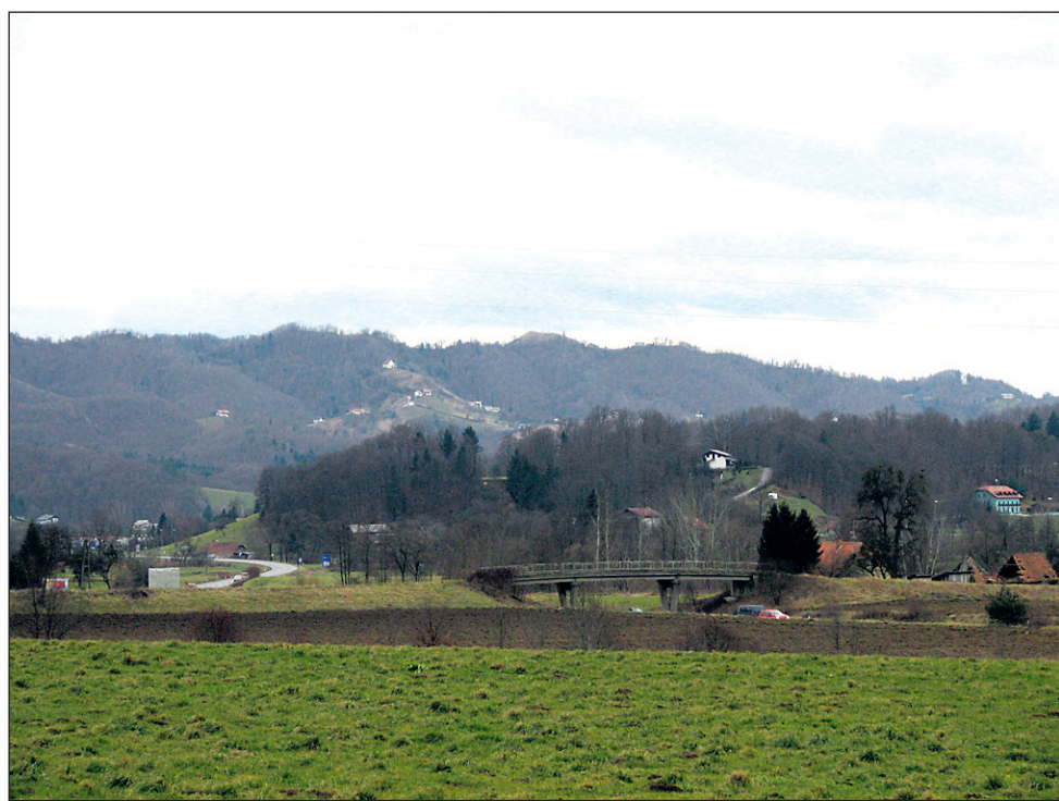
Podlehnikiški vodovod je delno sofinancirala tudi država; za morebitno pridobitev še kakšnega tolarja se bo potrebno zelo previdno pogajati ...
