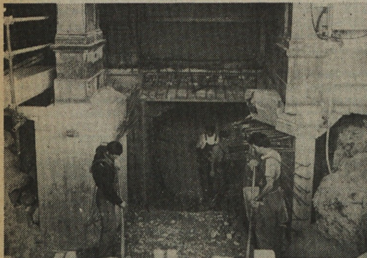
Za dostop v kletne prostore je bilo potrebno podpreti kamnite stebre, nato pa jim podbetonirati pet metrov globoke temelje.
