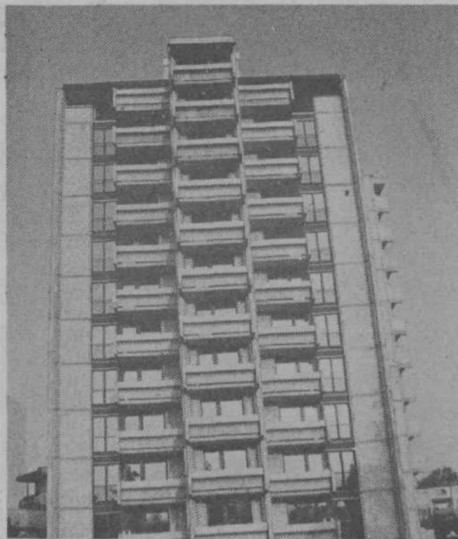
STOLPNICA NA KUZMIČEVI ŽE VSELJENA
