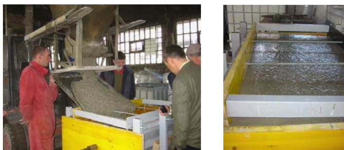
Slika 3.17: Vgrajevanje SCC mešanice v eni fazi, betonarna CGP Novo mesto
