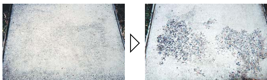
Slika 5.3: Primer luščenja betona zaradi zmrzovanja in tavanja v prisotnosti talilnih soli (PCA, 2003)
