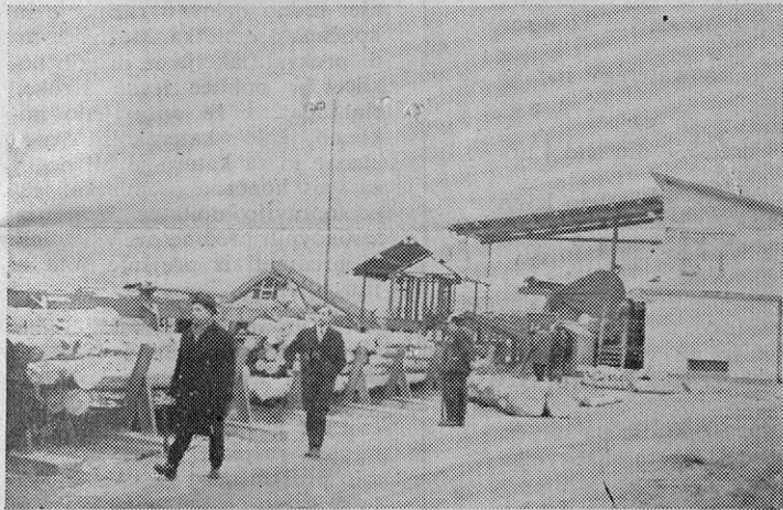
Sortiranje olupljene oblovine v bokse. V ozadju lupljenje, razžagova-nje na potrebne dolžine, elektronska izmera sortimentov po odje-malcih.
