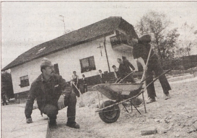
OBNOVE MEST - Če je Kostonjeva na Krki, kjer je pred prazniki nastala fotografija, še nedolgo tega dajala vtis propadajočega mesta, je zdaj vse drugače. Toliko gradbenikov, strojev in orodja na enem mestu najbrž ni bilo v Kostonjevi že lep čas. Urejanje, ki ima rep in glavo, je temeljito, vendar vsega tega še dolgo ne bi bilo, če bi sanacijo dolenskih Benet naložili zgolj krškemu občinskemu proračunu. Obnova Kostonjeve trenutno zaposluje mogoče več načrtovalske strokovne pameti in domišljije kot posamezna gradbišča v občinskem središču. Zato gre verjeti tistim, ki napovedujejo, da bo naslednja razvojna poteza v krški občini posodobitev mesta Krško v občinsko središče. Od tod do urejanja Krškega v središče bodoče pokrajine Posavje naj bi bil samo še korak. Nihče si pri omenjenih posegih ne domišlja, da je težje zgraditi mesto, kot mu vdahniti dušo. (Foto: L. M.)
