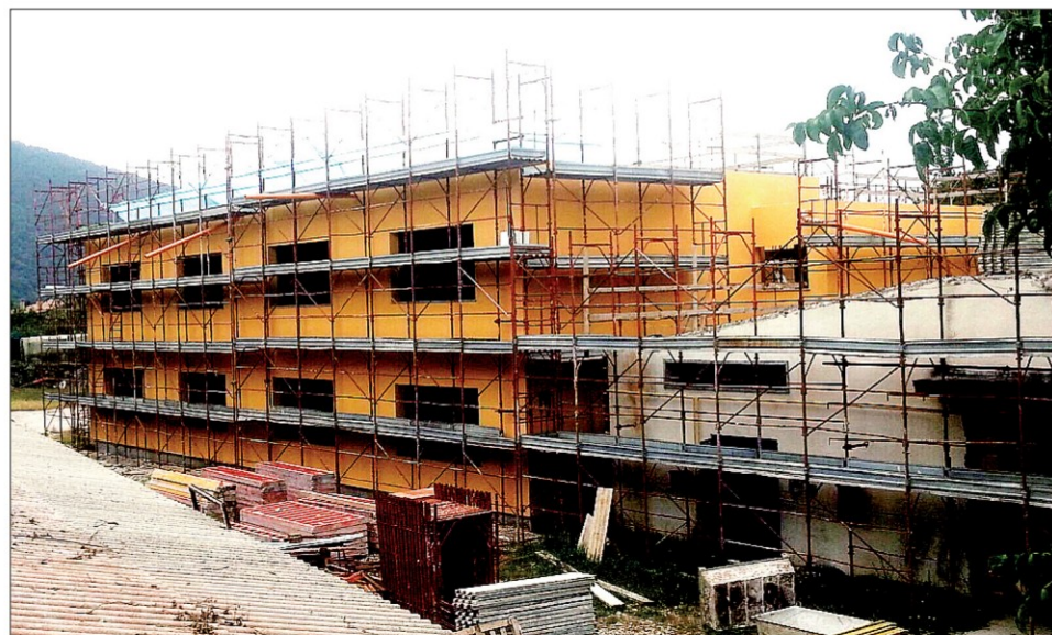
Dela za obnovo stavbe se nadaljujejo
